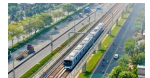
Operating Ben Thanh - Suoi Tien metro line
